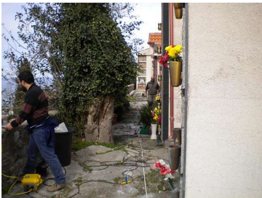
Foto 32. Esecuzione di Prova DPSH in postazione 3
