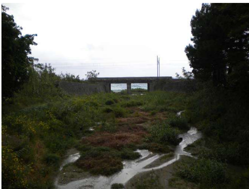
Foto 13. Il Palumbo alla foce prima dell'attraversamento ferroviario
