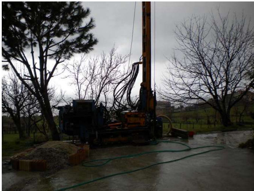
Foto 29. Operazioni di Sondaggio in postazione S1
