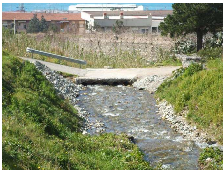
Foto 20. Attraversamento stradale nei pressi dell’Ospedale
